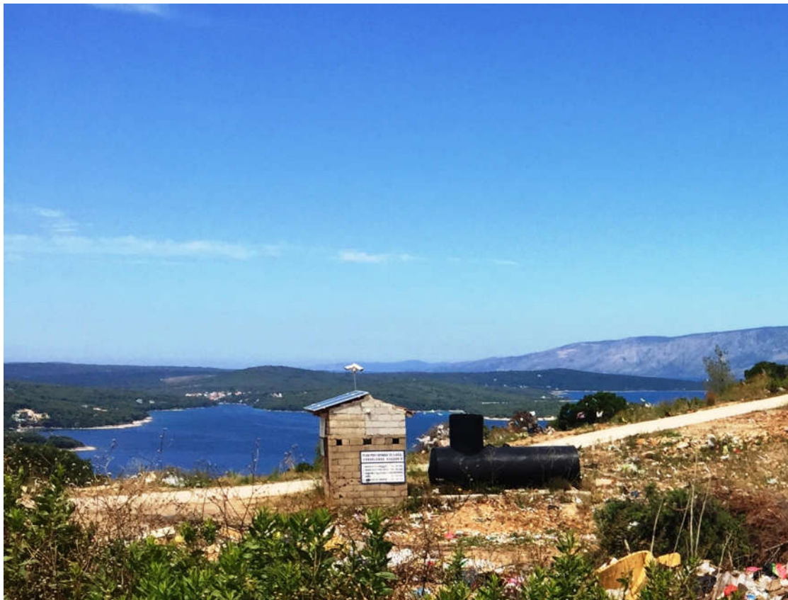
Slika 9. Kućica sa videonadzorom i cisterna za vodu na odlagalištu komunalnog otpada Prapatna, Jelsa. Fotodokumentacija Hudec Plan d.o.o., 2016.g.
