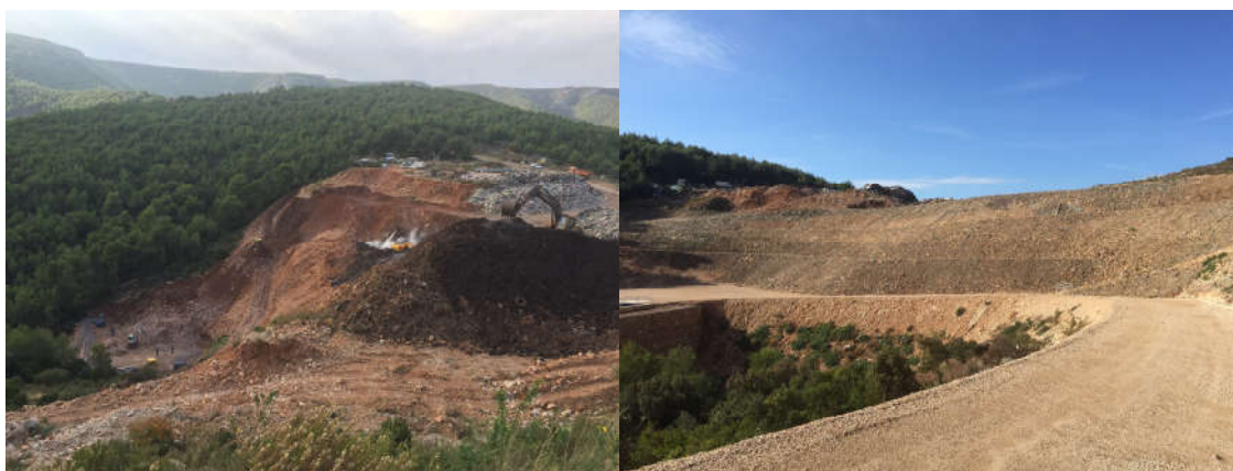
Slika 1. Sanacija požarišta na odlagalištu otpada Prapatna, Jelsa , studeni 2016.g. i stanje studeni 2017.godine (desno).
